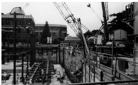
建設中の現会館
